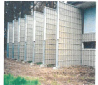
Lärmschutzwand an einer Schießanlage
